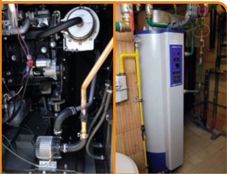
Moteur de la PAC réversible gaz naturel Accumulateur d'ECS à gaz naturel
